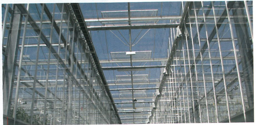
1 Saubere Scheiben führen zu Ertragserhöhung und gleichzeitig zur Minderung des Heizenergieaufwands.
