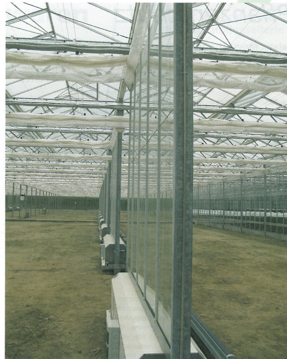
Besonders auffällig sind die als Doppelwand gestalteten Lufteinzugskanäle, über die die warme und feuchte Luft zu den Wärmetauschern gelangt Fotos: Körner
